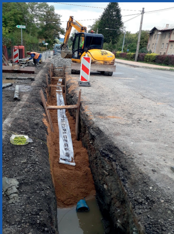
25. 9. 2018 Kontrolní den stavby vodovodu v ulici 9. Května v Rudě nad Moravou – 1663 m obnoveného vodovodu.
