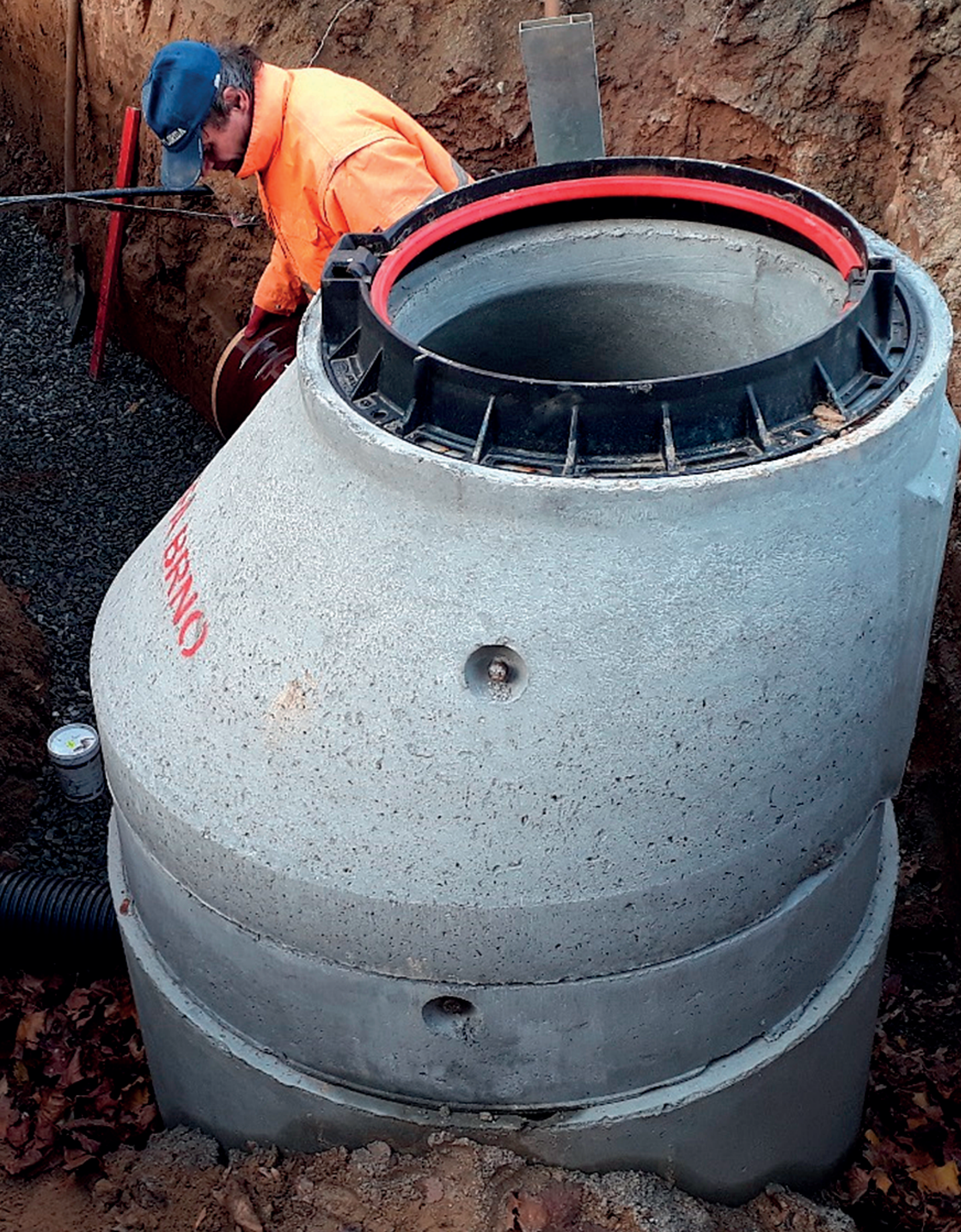
1. 11. 2018 Kontrolní den výstavby vodovodu a kanalizace na sídlišti Severovýchod v Zábřehu.
