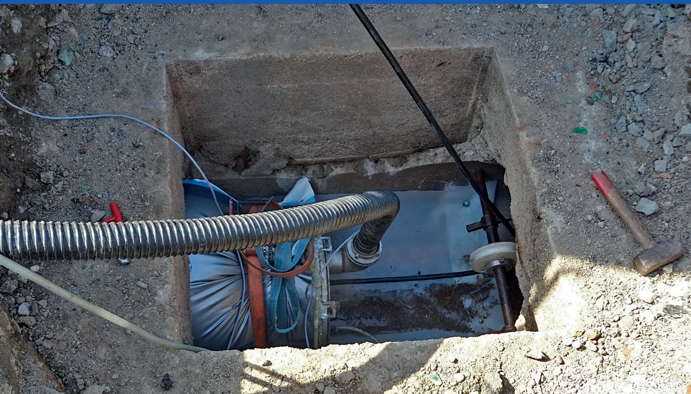
13. 11. 2018 Bezvýkopová obnova kanalizačního potrubí v ulici Vrchlického v Mohelnici – UV LINER Technologie.
