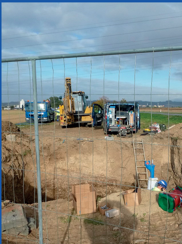
Výstavba vodovodu Leštinská v Zábřehu – koordinace s výstavbou cyklostezky – 1416 m obnoveného vodovodu.
