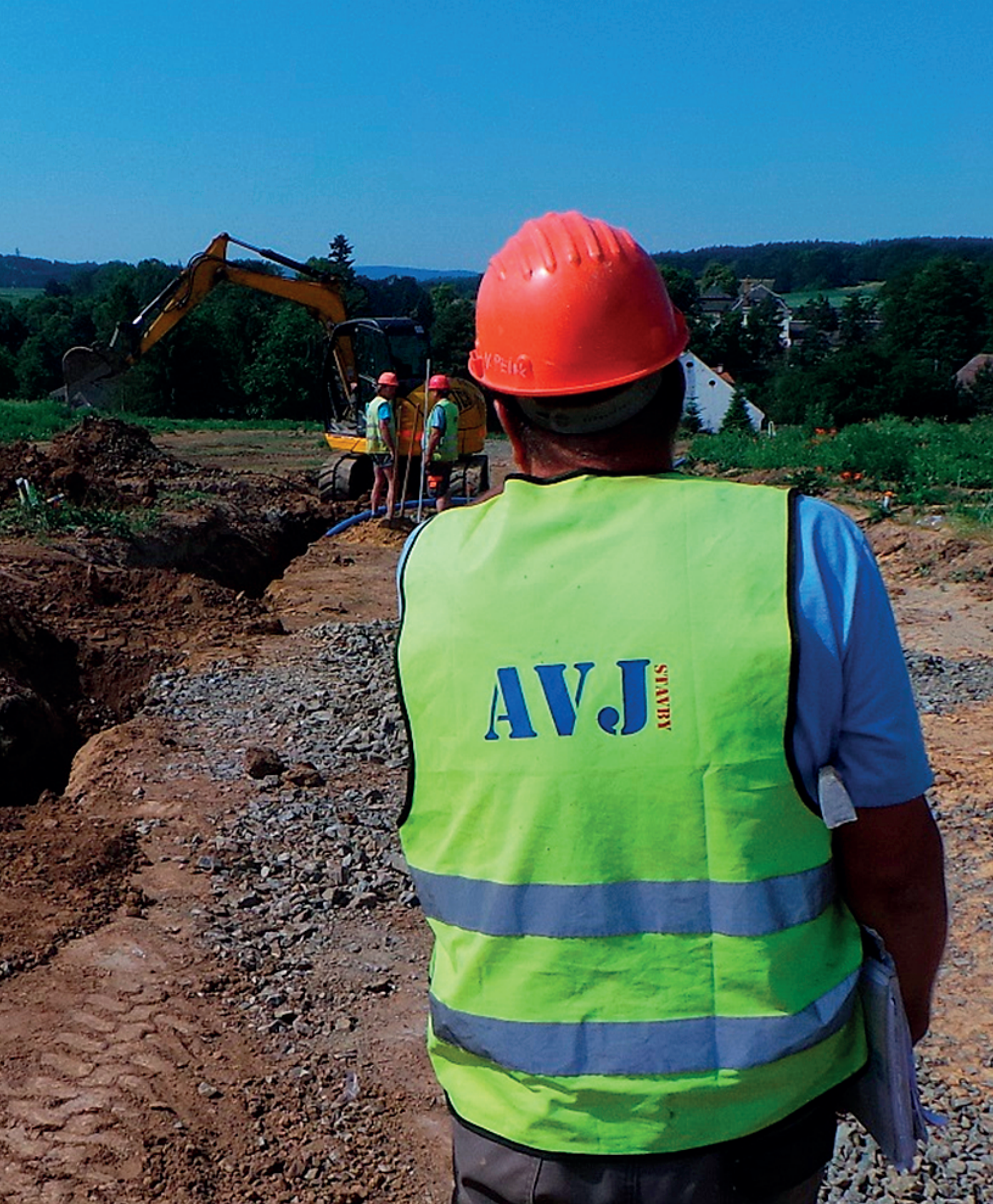
31. 5. 2018 Kontrolní den výstavby nového vodovodu a kanalizace v lokalitě K Pešti v Lošticích.
