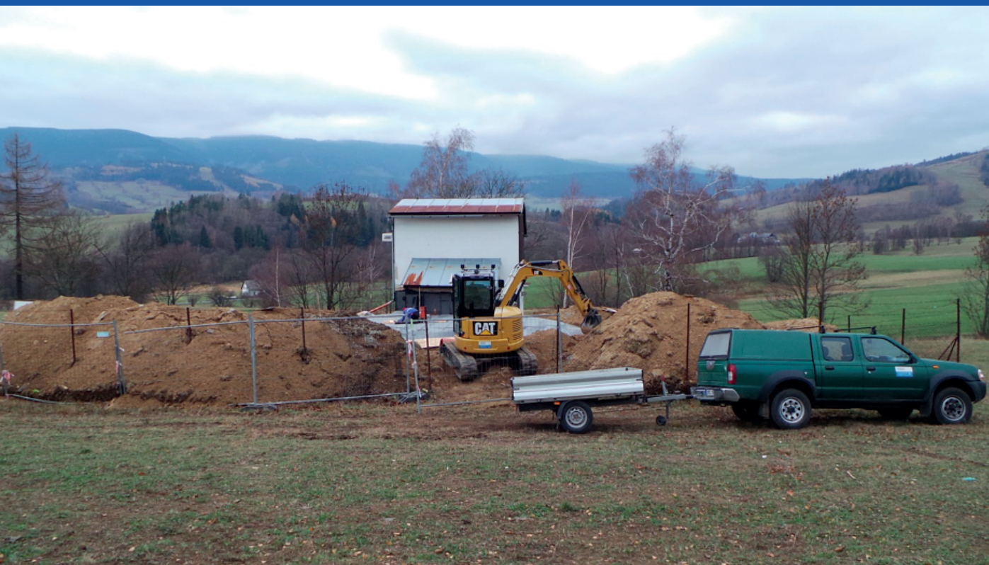
16. 11. 2018 Kontrolní den generální opravy Vodojemu Květná Staré Město
