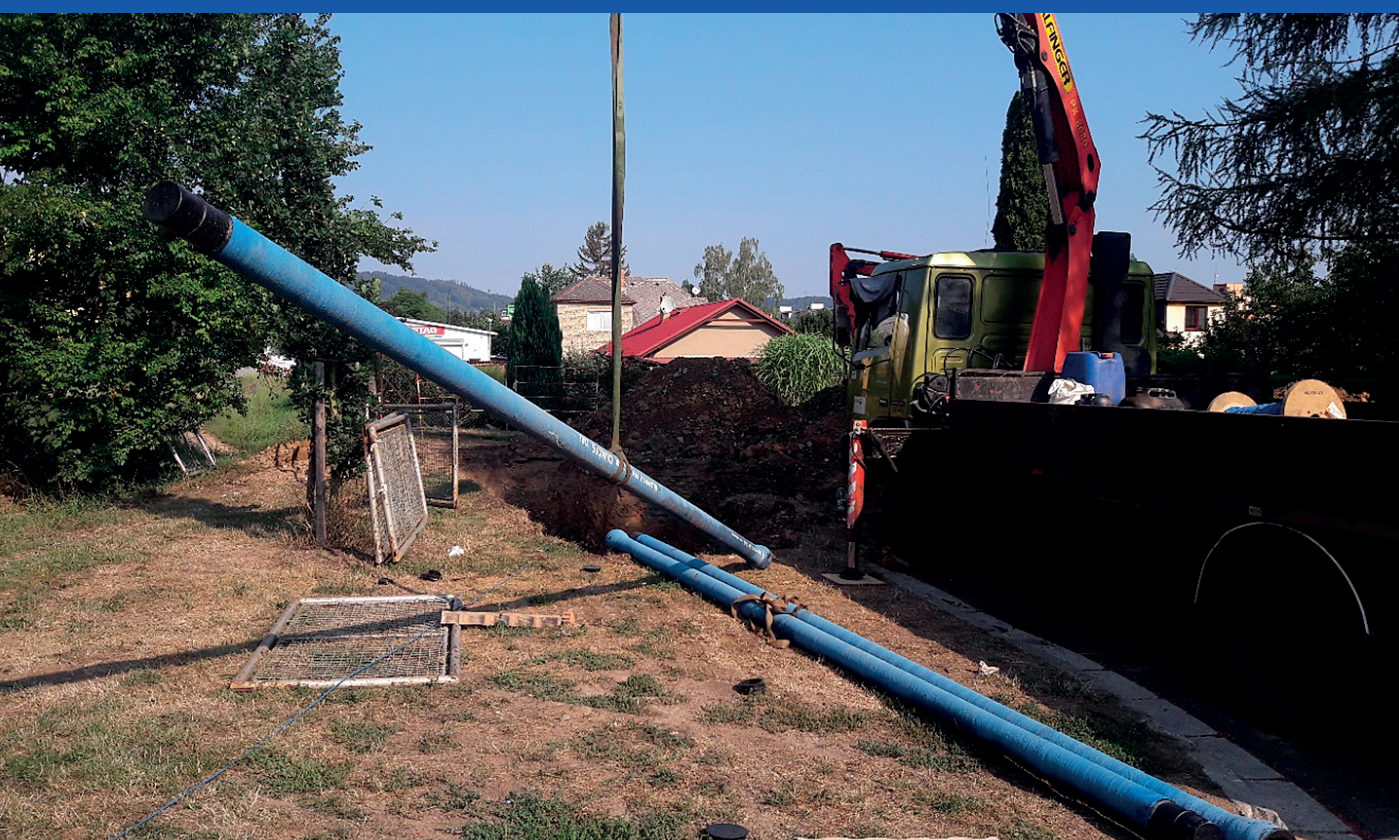
9. 8. 2018 Kontrolní den. Výstavba kanalizace a vodovodu v ulici Školní v Šumperku – berstlining vodovodu.
