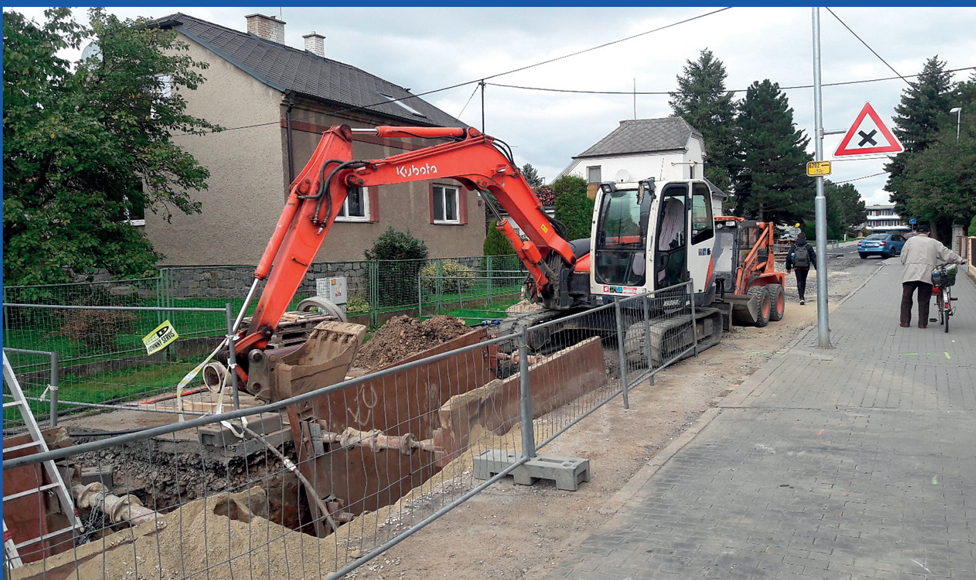
4. 10. 2018 Kontrolní den výstavby kanalizace v ulici Staškova v Mohelnici.
