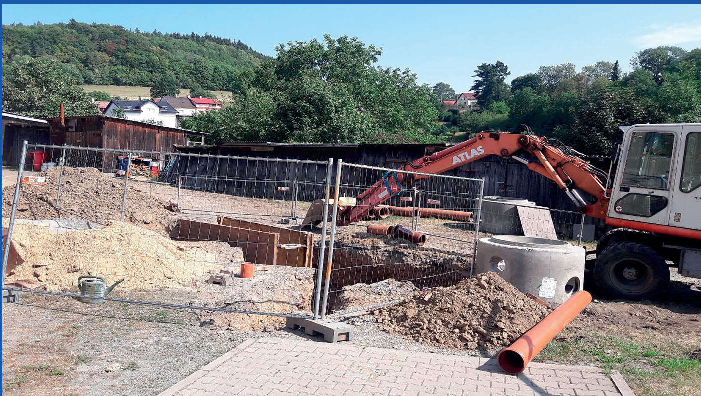
1. 8. 2018 Kontrolní den výstavby kanalizace v lokalitě bytových domů Kolonka Mírov.
